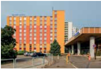
Budova ŠD UKF Nitra a FF UKF na Slančíkovej 1 (foto: J. Novák)
