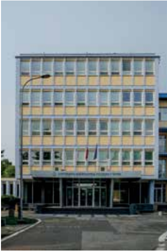
Budova Rektorátu UKF a sídlo FPV UKF na Tr. A. Hlinku 1 (foto: J. Novák)
