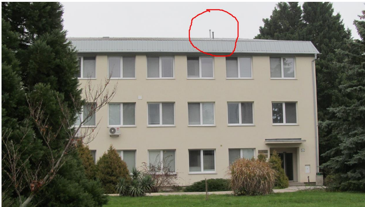
Trojpodlažný objekt s plechovou strechou
