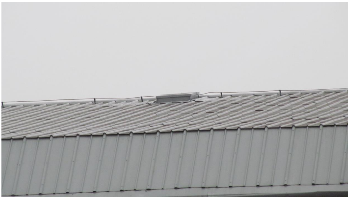
Výlez na strechu s povalového priestoru
