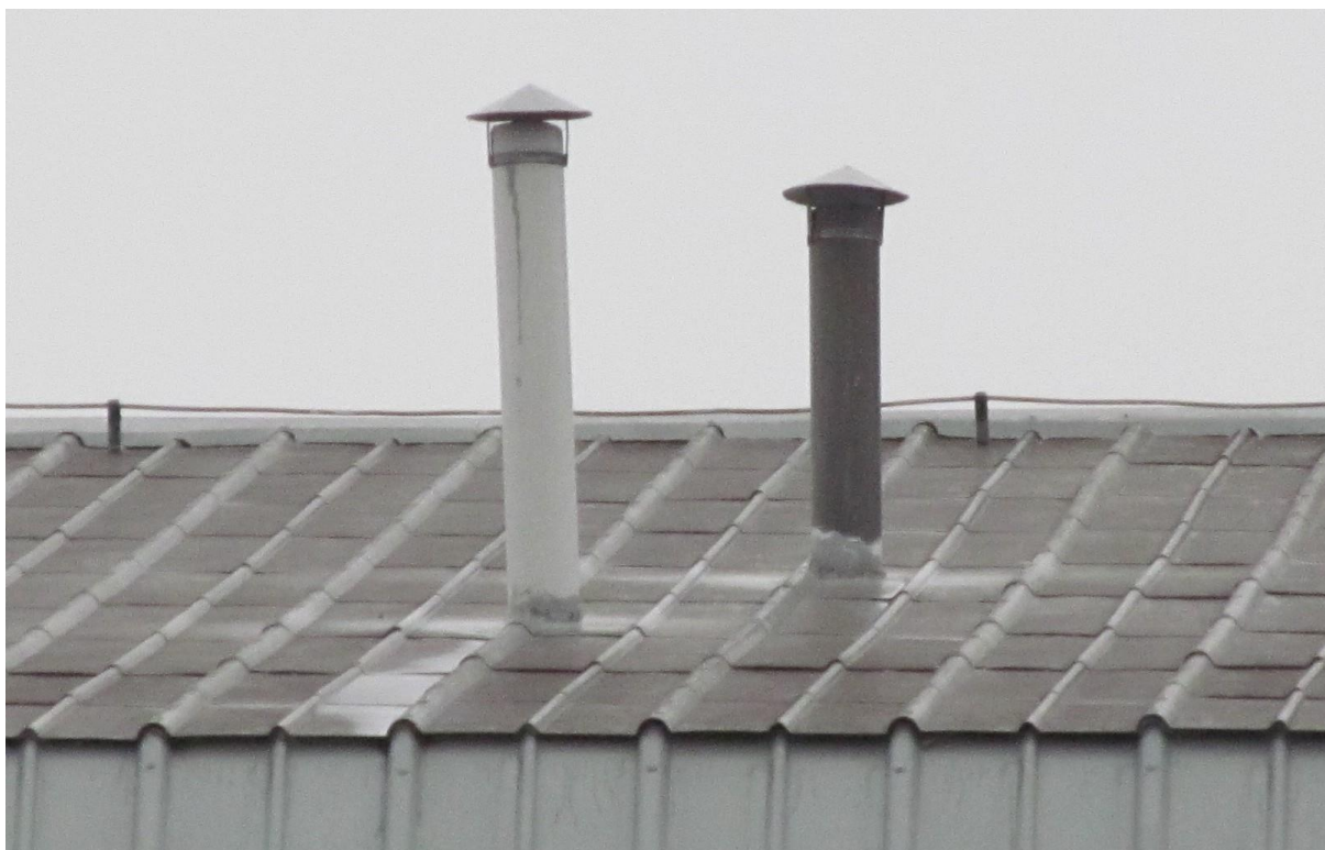
Detail odvetrávacích potrubí – prestupov cez strechu
